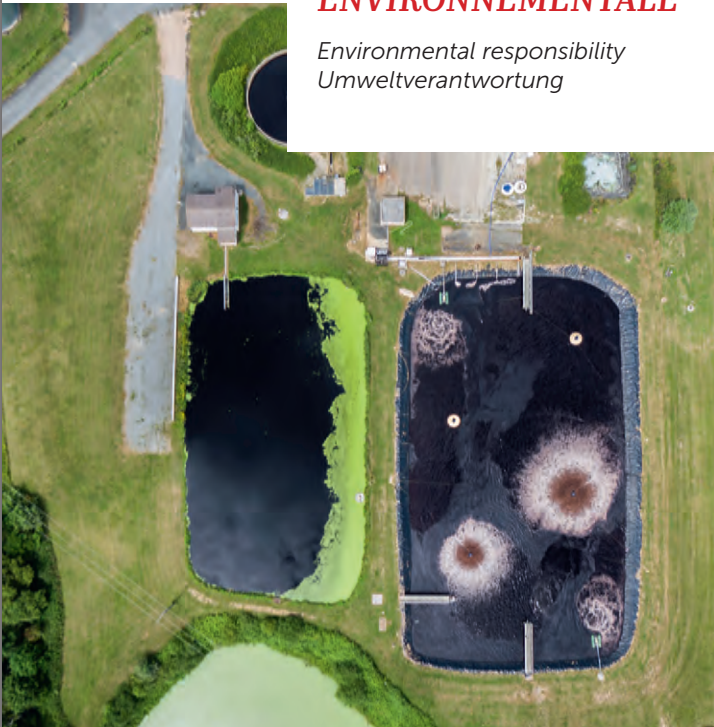
Station d'épuration sur notre site On-site water treatment plant Kläranlage an unserem Standort
